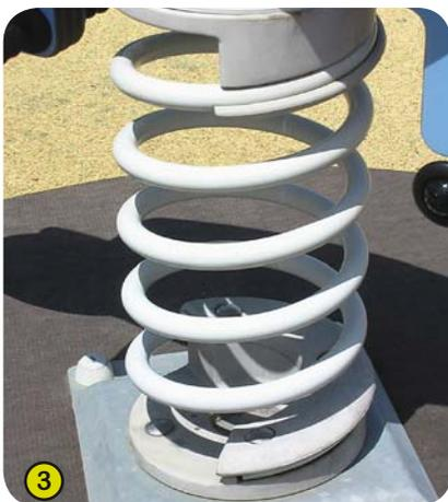
3- **Los muelles** son de acero 35SCD6. La superficie del muelle se trata después con granalla pretensada con capas de preparación de zinc y 2 capas de polvo de poliéster de 100 micrones. La pieza de fijación (Patente Proludic) en poliamida cargada garantiza una longevidad y una seguridad excepcional al sistema.
