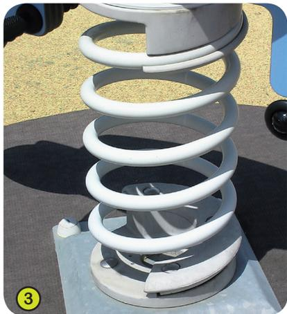
3- **Los muelles** son de acero 35SCD6. La superficie de muelle se trata después con granalla pretensada con capas de preparación de zinc y 2 capas de polvo de poliéster de 100 micrones. La pieza de fijación (Patente Proludic) en poliamida cargada garantiza una longevidad y una seguridad excepcional al sistema.
