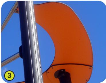
3- **Versión tubos** : los techos están compuestos de tableros coloreados elaborados a partir de un material compacto de 13 mm de espesor. Compuesto en un 70% de fibra de madera blanda y en un 30% de resina termoendurecida, presenta una excelente resistencia a la intemperie. Las caras coloreadas están tratadas a base de resinas acrílicas de poliuretano pigmentadas, lo que garantiza una perfecta resistencia a los rayos ultravioletas y a las degradaciones.
