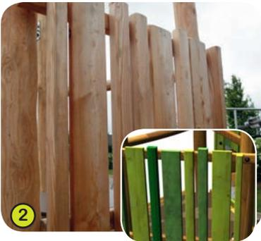
2- **Los paneles, muros de escalada, túneles y vigas de los elementos de equilibrio** están contruidos en alerce (tamaño de piezas 140 x 27 mm / 45 x 68 mm). El alerce es resistente y duradero en estado natural.
