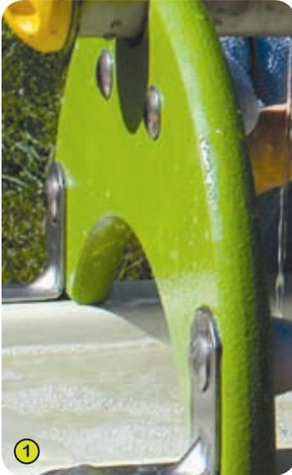
1- **Los paneles lacados** se elaboran a partir de un contrachapado alta calidad de 22 mm de grosor, compuesto de láminas alternas de abedul. El proceso de pintado se efectúa mediante pulverización robotizada de tres capas de laca de poliuretano sin plomo y con un acabado de barniz como protección. Los cantos se protegen con varias capas de apresto poliuretano elástico.
